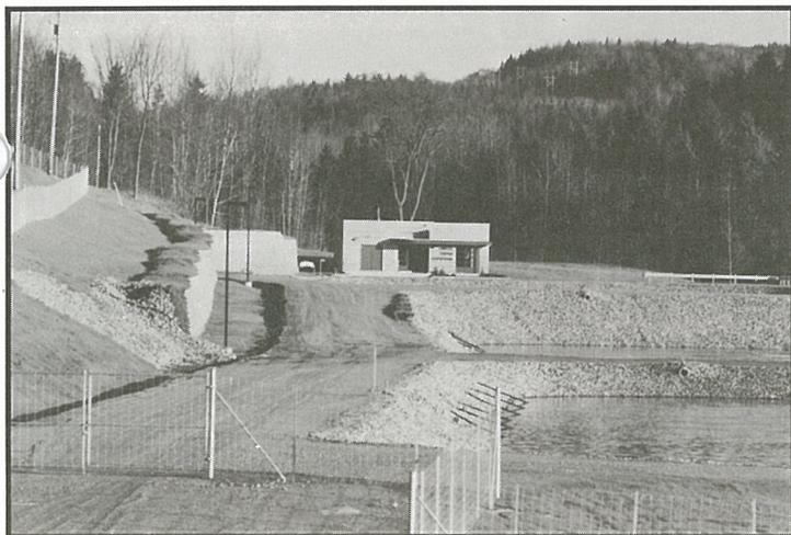
À chaque semaine la Municipalité doit prélever des échantillons d'eau à l'entrée et à la sortie des étangs pour mesurer l'efficacité de nos installations. Selon les derniers rapports d'analyse, l'eau est traitée à 87 % avant d'être rejetée à la rivière. Les municipalités de L'Ascension et de L'Annonciation contribuent elles aussi à la dépollution de cette rivière et ce depuis 1992. Cette belle rivière retrouvera sans doute sa vocation récréo-touristique au cours des prochaines années.
