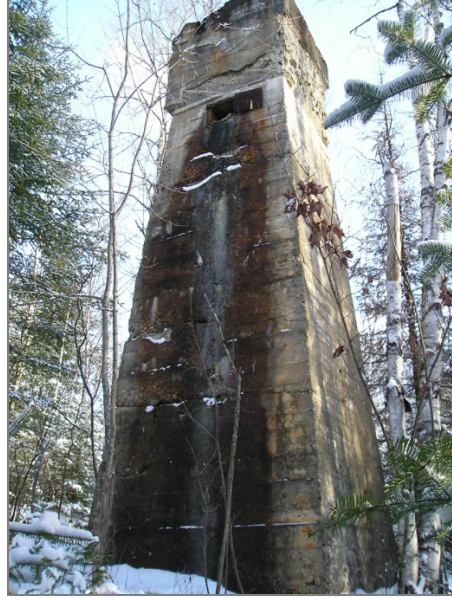
Cheminée du moulin
