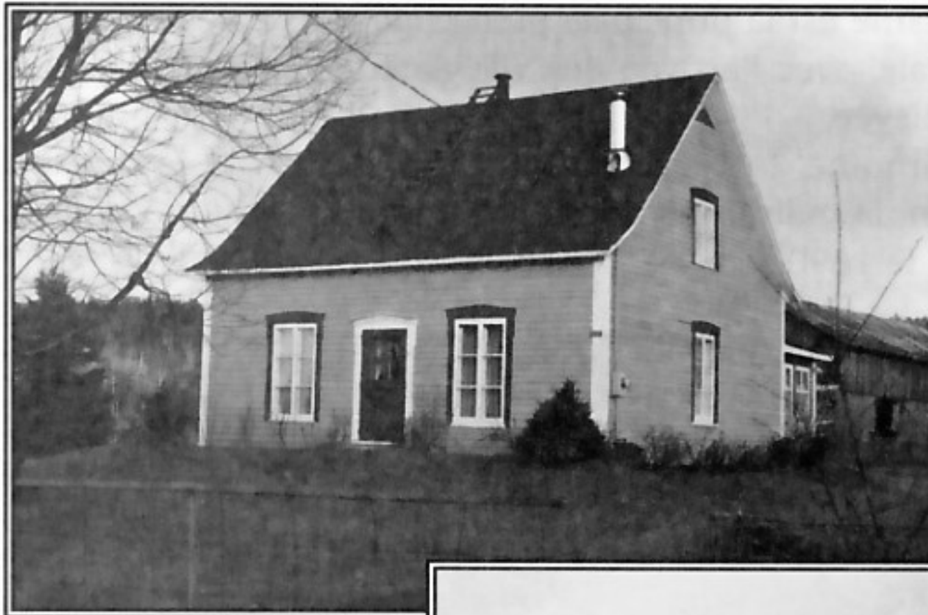
Maison Thomas Labonté, chemin du Moulin, érigée en 1901.
